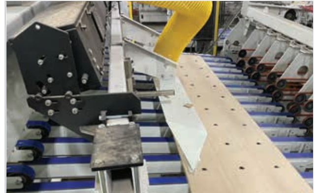
Montage über vorhandenes Förderband an Stanzen und Inliner Maschinen
